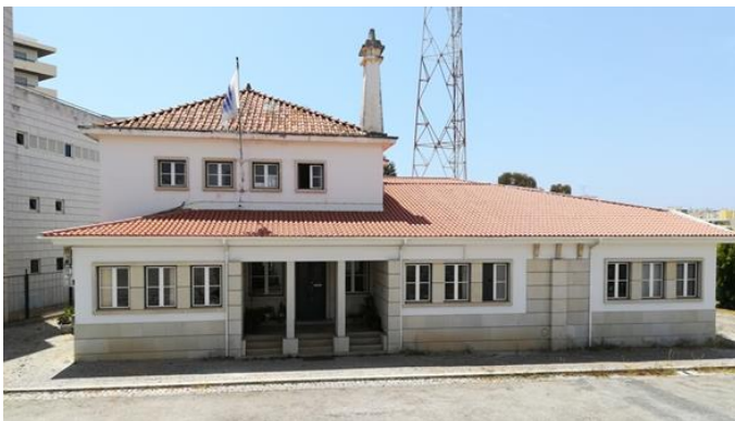
Fig. 13. Fotografia do edifício principal – vista da fachada principal (virada a norte).
