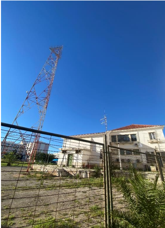
Fig. 14. Fotografia do edifício principal – vista da fachada traseira (virada a sul).
